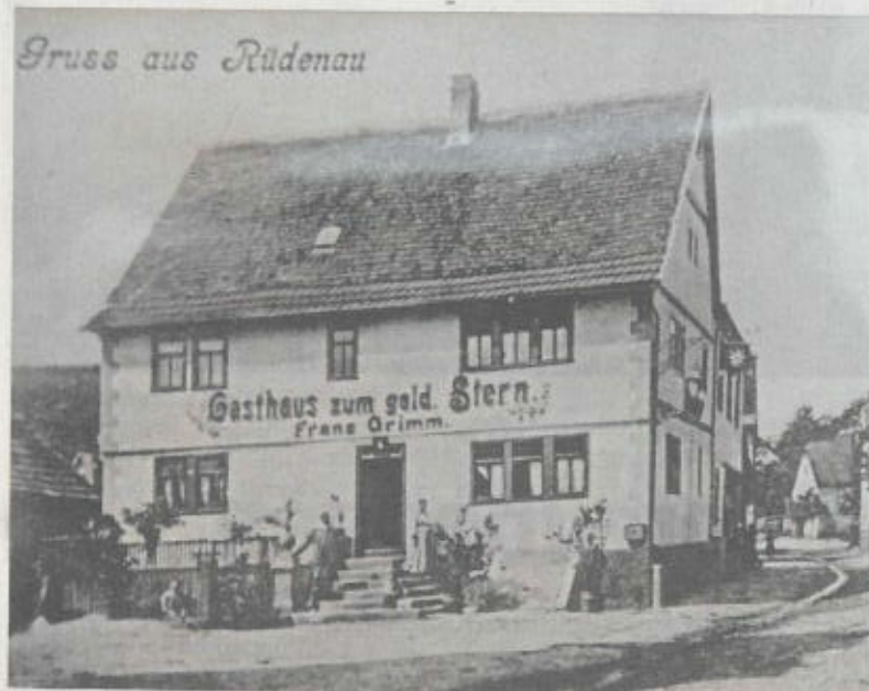
Ohne Anbau: Der Stern ist in seiner Geschichte mehrmals umgebaut worden.
